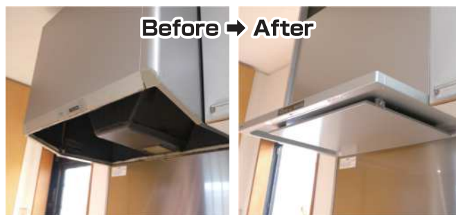
レンジフード交換
