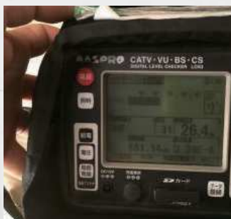
アンテナ工事
